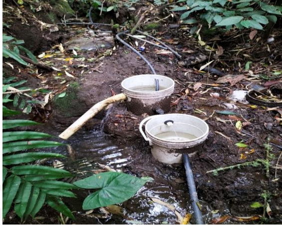
Implementación de la obra de control de caudal de Cornare
