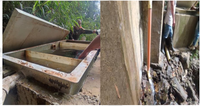
Figura 4. Desarenador y Rebose
