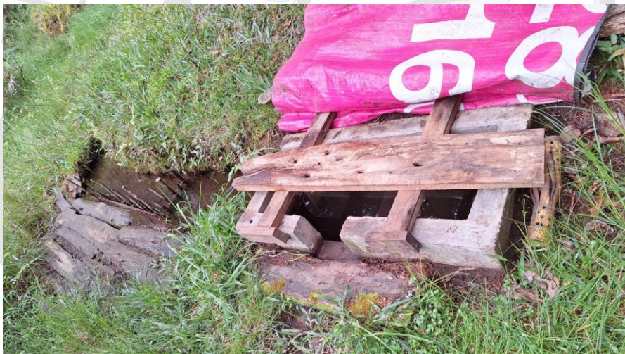
Imágenes 1: Obra de captación y control.
