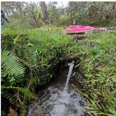
Imágenes 2. rebose de la obra a la fuente
