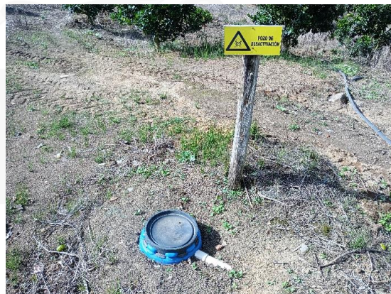
Pozo de desactivación
