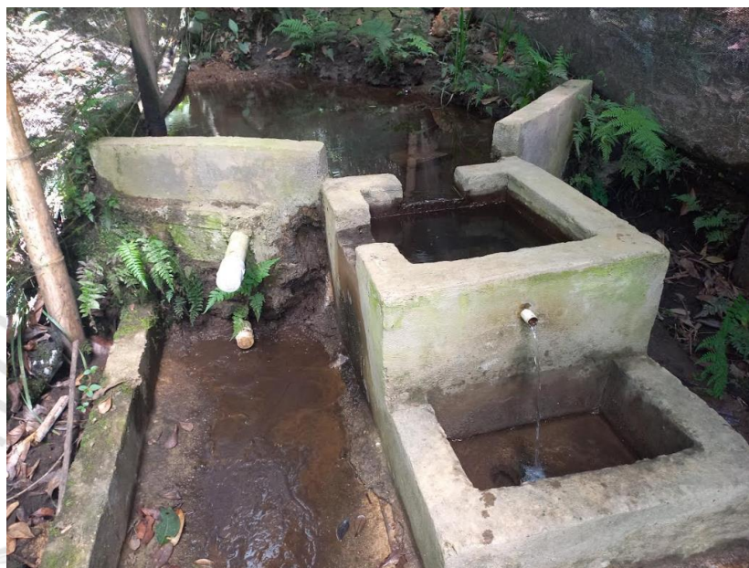
Imagen 1. Obra de captación.
