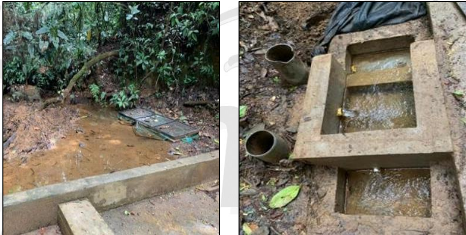
Figura 22. Fuente Seminario y obra de control
