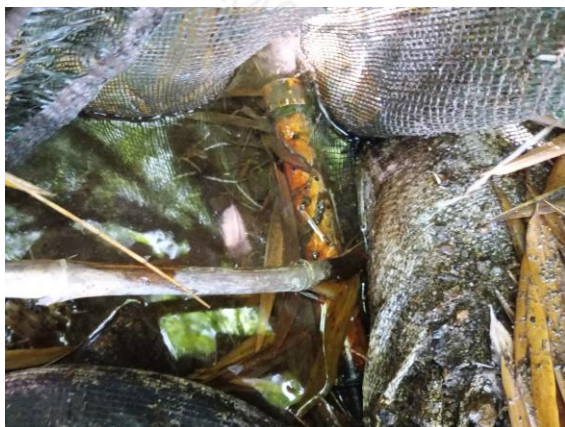
Obra de control de caudal
