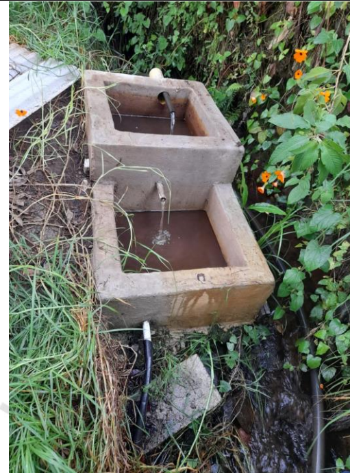
Imagen 2: Obra de Captación y Control del Caudal
