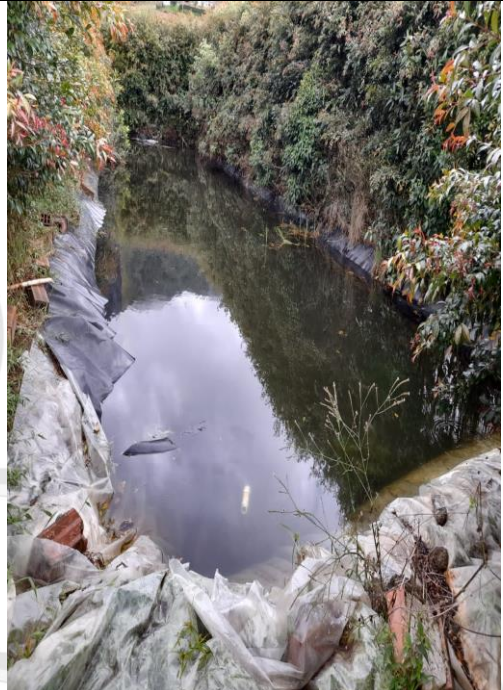
Imagen 3: Reservorio de Almacenamiento impermeabilizado
