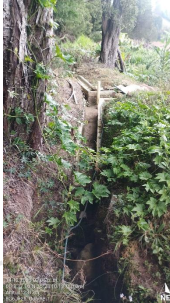
Imagen1. Obra de captación
