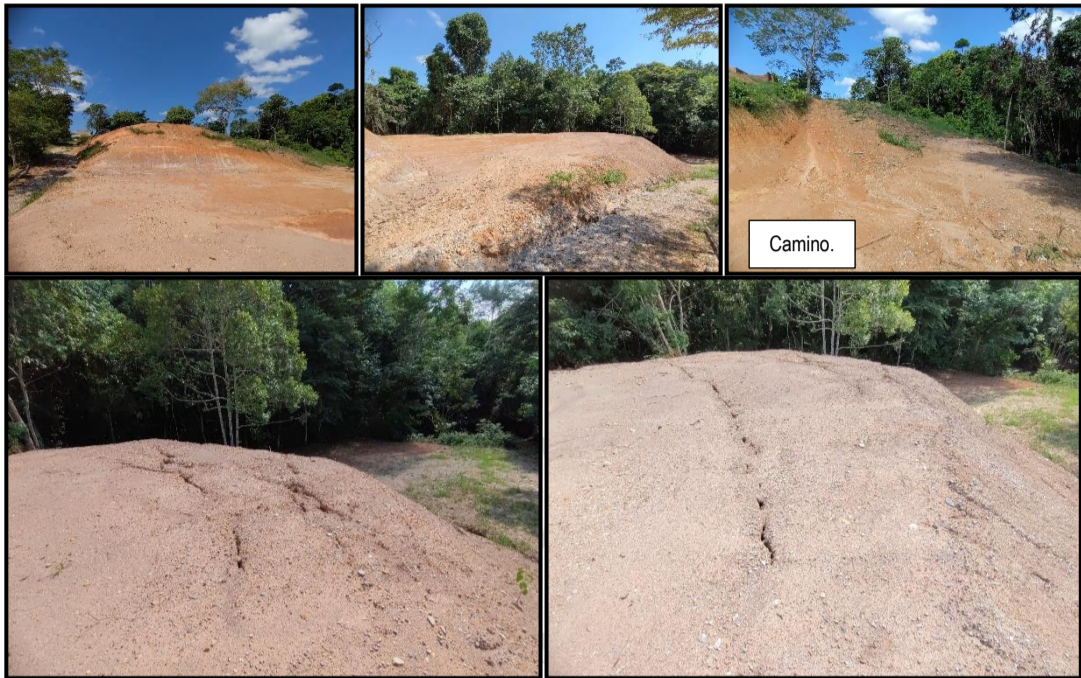
Imagen 5. Cornare. 2023. Explanación 3 y grietas presentes en el lleno.
