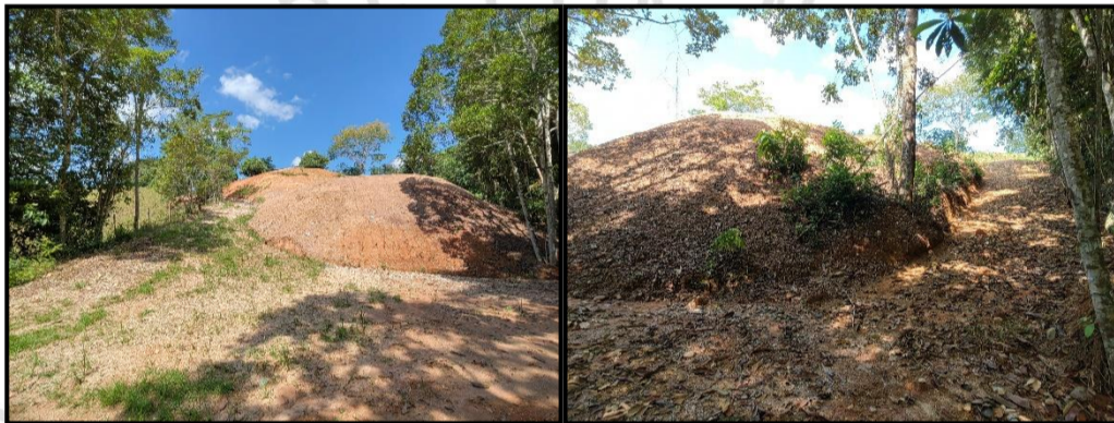
Imagen 3. Cornare. 2023. Explanación 2 y talud de explanación 3.
