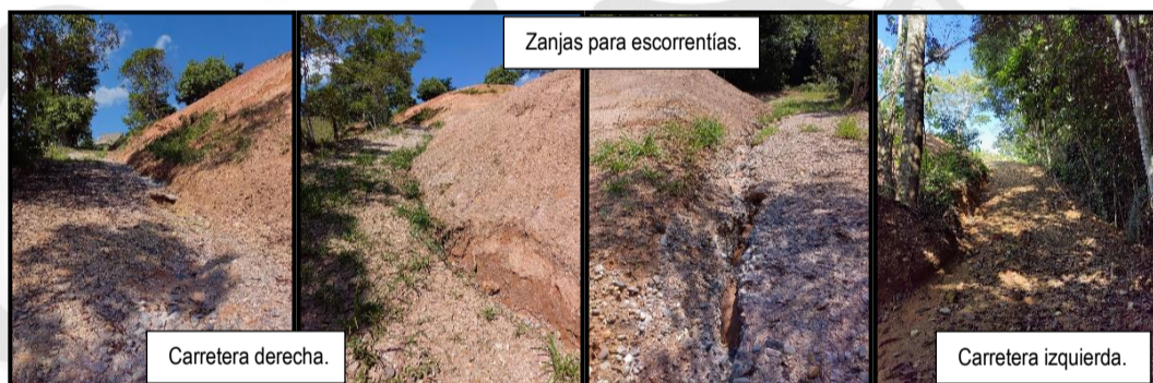
Imagen 4. Cornare. 2023. Carreteras que llevan a la explanación 2 y zanjas para desagüe de escorrentías.
