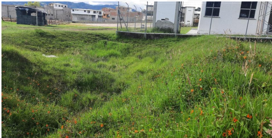
Sitio donde quizás pudo estar ubicada la Zanja de Infiltración
