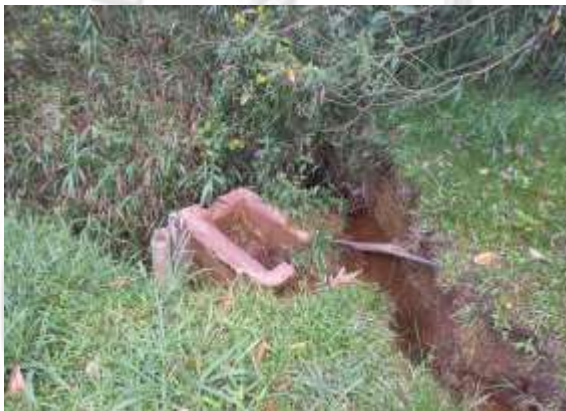
Imagen 1. Restos de obra en mampostería
