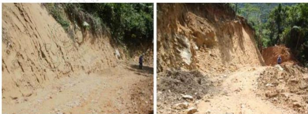
Figura 7. Surcos en los costados y desprendimientos del terreno de la vía sin permiso. Fuente: CORNARE (14/08/2023)
