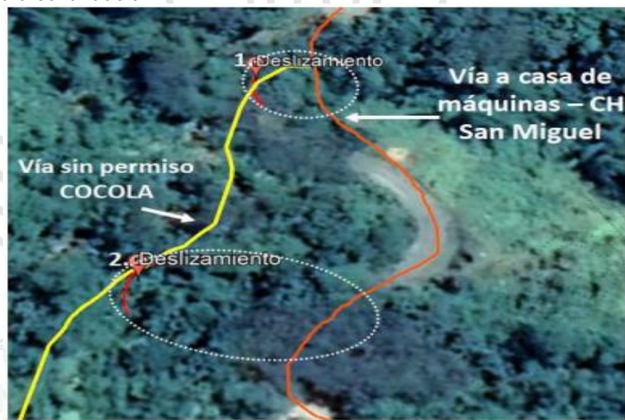
Figura 3. Deslizamientos en vía a casa de máquinas generados por la apertura de la vía sin permiso COCOLA. Fuente: Google Earth, 2018 y CORNARE, 2023
