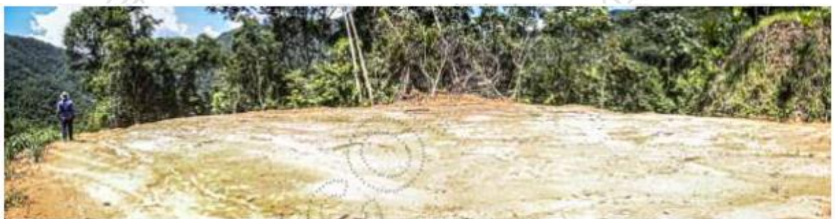
Figura 18. Explanación realizada en apertura de vía realizada por Teodomiro Salazar. Fuente: CORNARE (14/08/2023)
