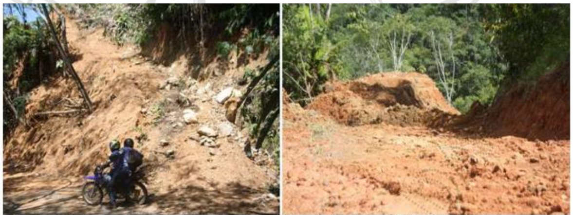
Figura 12. Punto de partida de la vía desde la vía a casa de máquinas y punto de finalización de la vía cerca de la torre 003 de la LT de la CH San Miguel. Fuente: CORNARE (14/08/2023)
