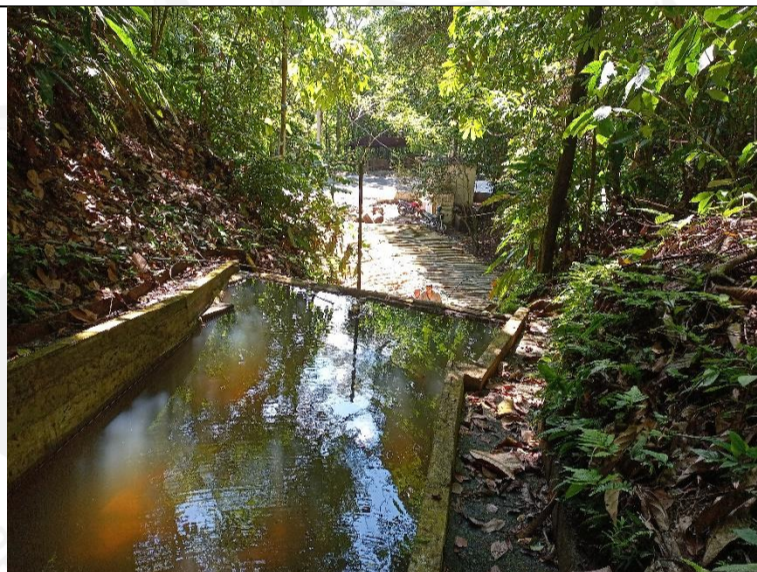
Imagen 2. Obra de captación en la corriente superficial denominada La Perla.
