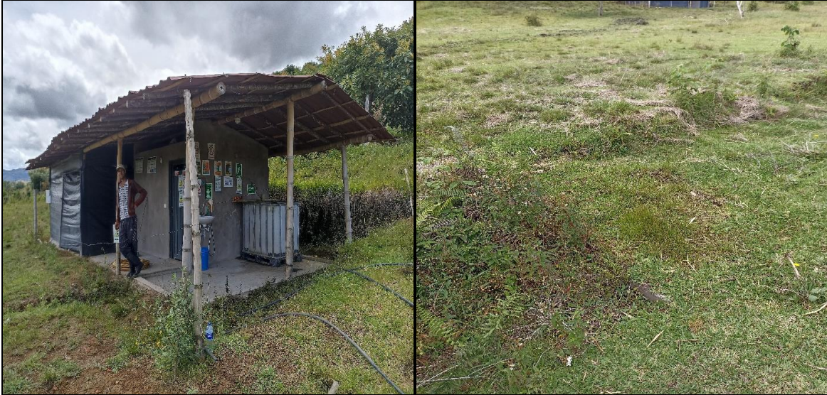
Caseta preparación mezclas
