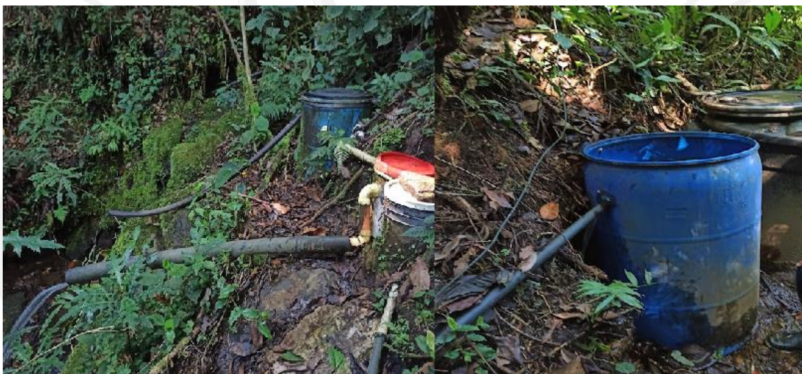
Imagen 2. Desarenadores y tanque de almacenamiento de 250 L de capacidad en polietileno.
