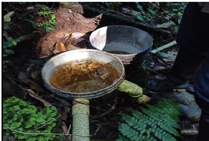
Imagen 1. Obra de captación y derivación de caudales-Diseño Económico.
