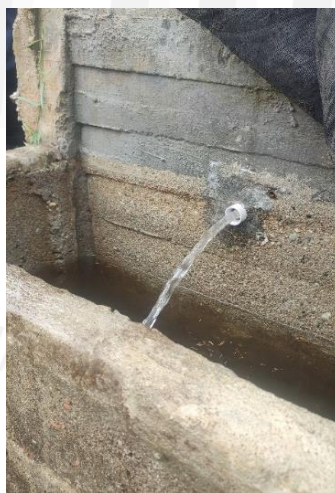
Figura 1. Obra de control de la fuente Quebrada Piedras Blancas
