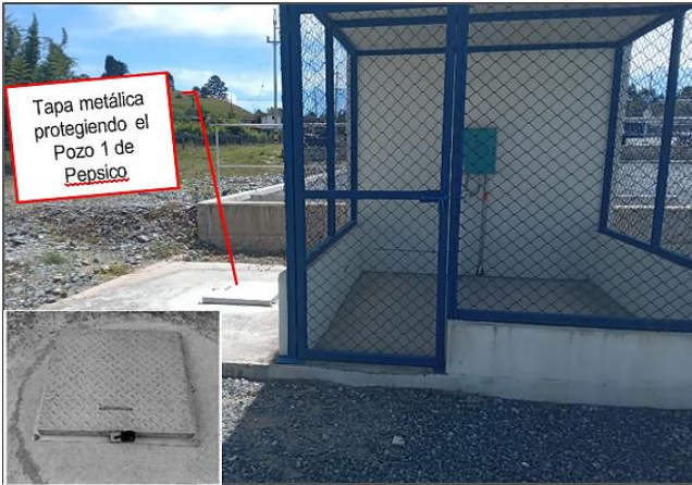
Figura 1. Pozo 1 de Pepsico, habilitado como pozo de observación del acuífero del Valle de San Nicolás.
