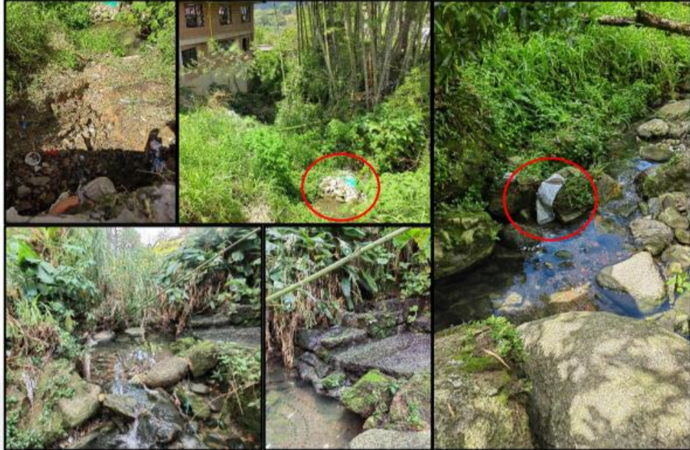
Imagen 1. Cornare. 2023. Estado actual de la fuente hídrica inspeccionada en el sector La Granja con residuos sólidos y restos de escombros en su interior.
