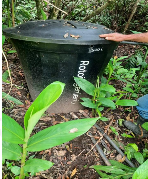
Tanque de almacenamiento con sistema de control de flujo tipo Flow Master
