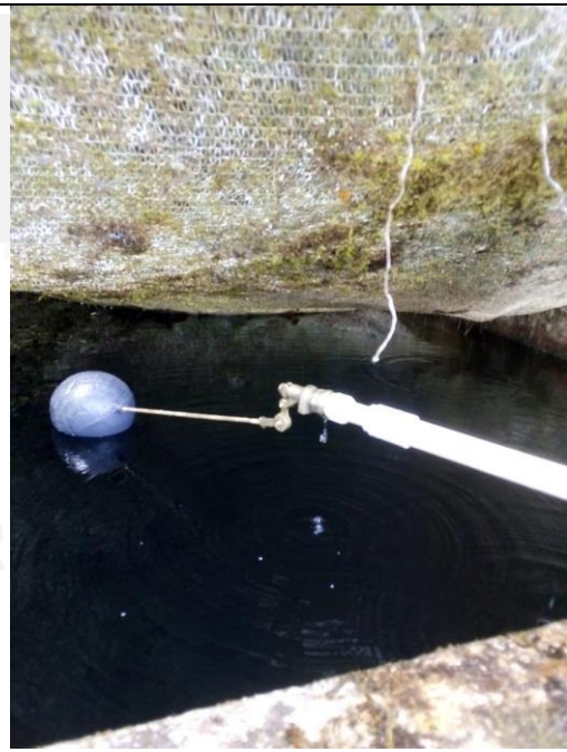
Imagen 2: Sistema Control de Flujo
