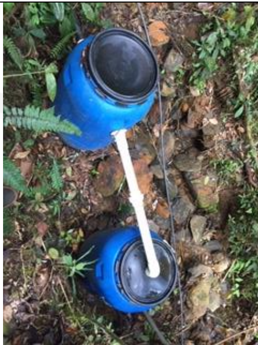
Imagen 1: Sistema de Captación del Caudal
