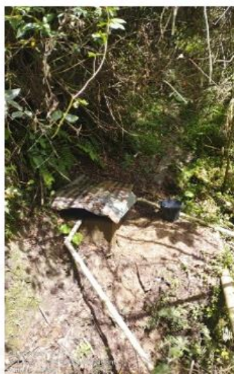
Imagen3. Obra de captación.
