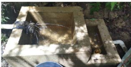
Imagen2. Obra de captación
