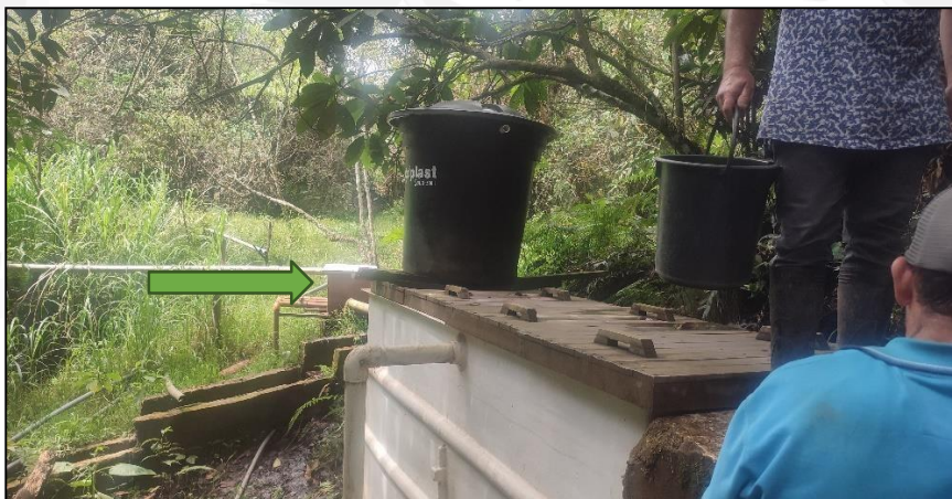
Figura 1. Obra de control de caudal
