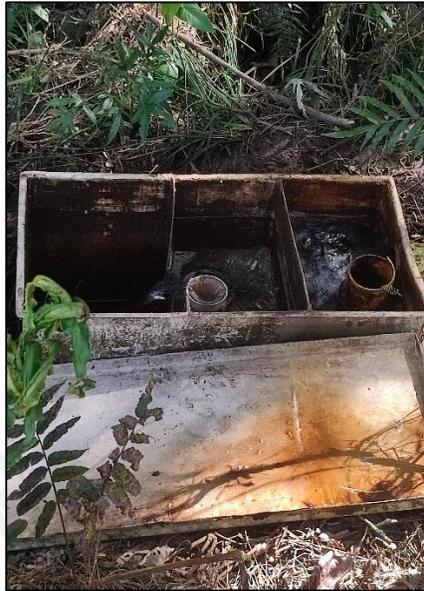
Figura 3. Obra de control de la fuente Borbollones 3 (Captación 5)
