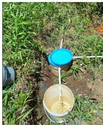
Imagen 1 y 2. Obra de captación y Control
