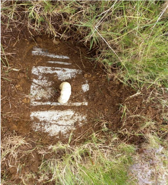
Pozo séptico instalado
