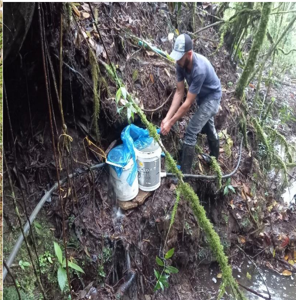
Obra de control de caudal implementada.
