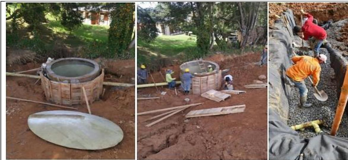
**Evidencia Fotográfica anexada por el interesado, correspondientes al sistema de disposición del vertimiento (Pozo de absorción y campo de infiltración integrado).**
