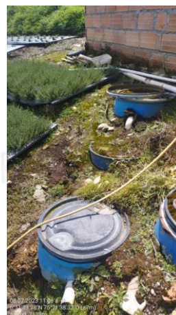
Imagen6. Pozo de desactivación.
