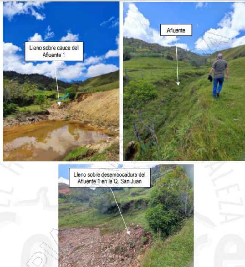
Foto 7. Intervención del Afluyente 1 con disposición de lleno sobre su cauce. Fuente: Cornare, 2023.
