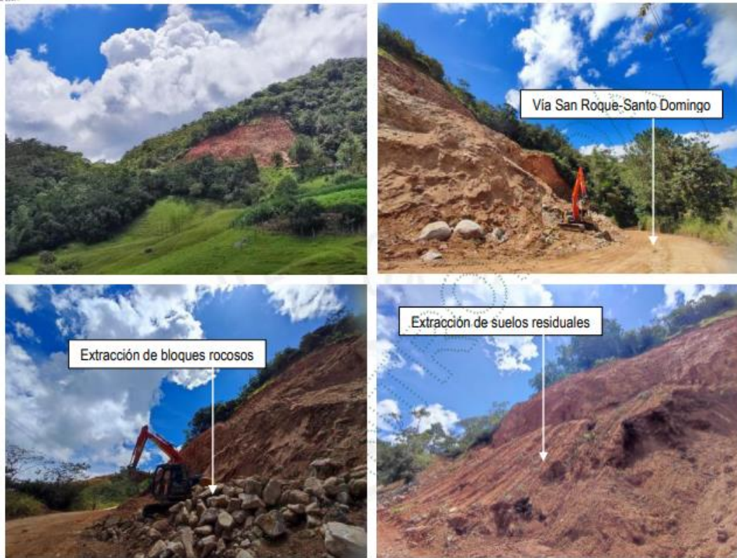
Foto 2. Cantera en la vía San Roque – Santo Domingo. Fuente: Cornare, 2023.
