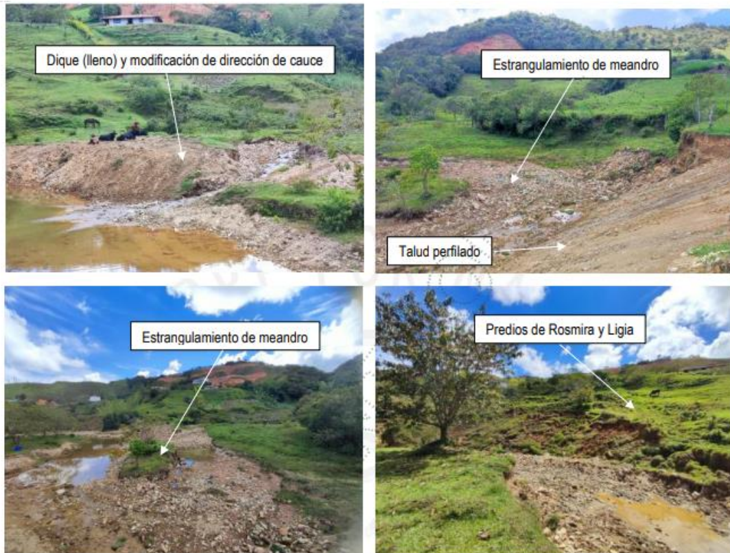
Foto 3. Modificación del cauce de la quebrada San Juan. Fuente: Cornare, 2023.
