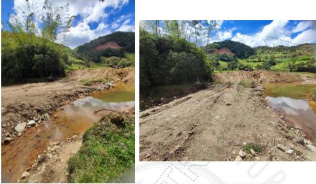
Foto 4. Dique en costado oeste de la quebrada San Juan. Fuente: Cornare, 2023.
