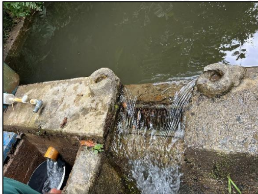
Figura 2. Obra de control implementada en campo
