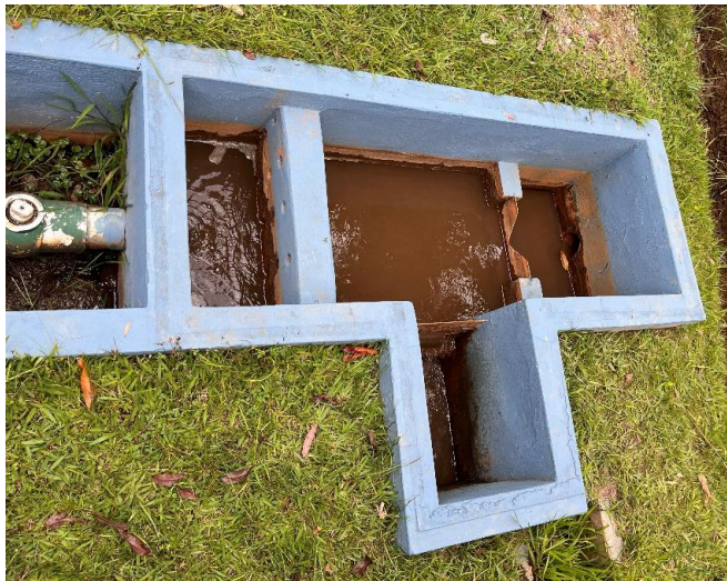
Obra de control fuente la Noreña, acueducto La ENEA.
