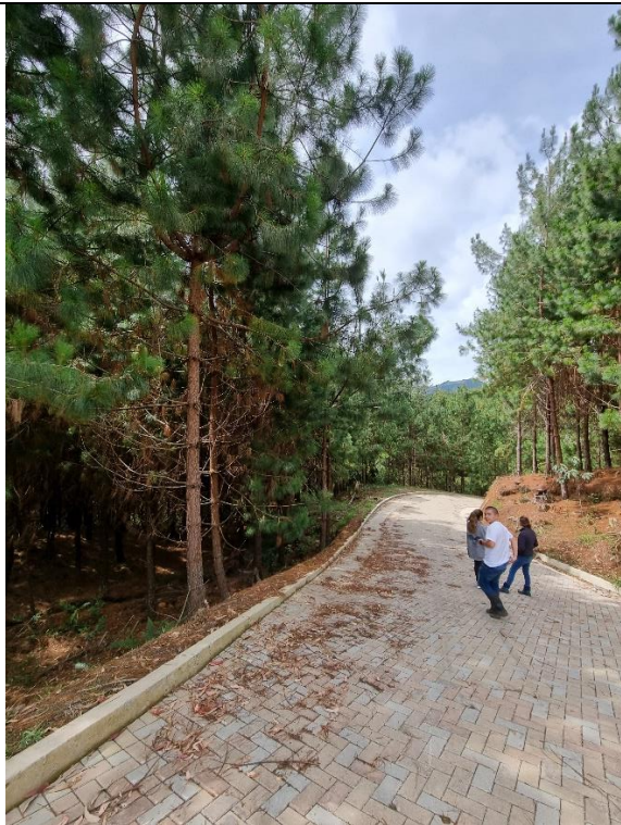
Imagen 3. Zona de árboles talados y vía construida resolución RE-02036-2022
