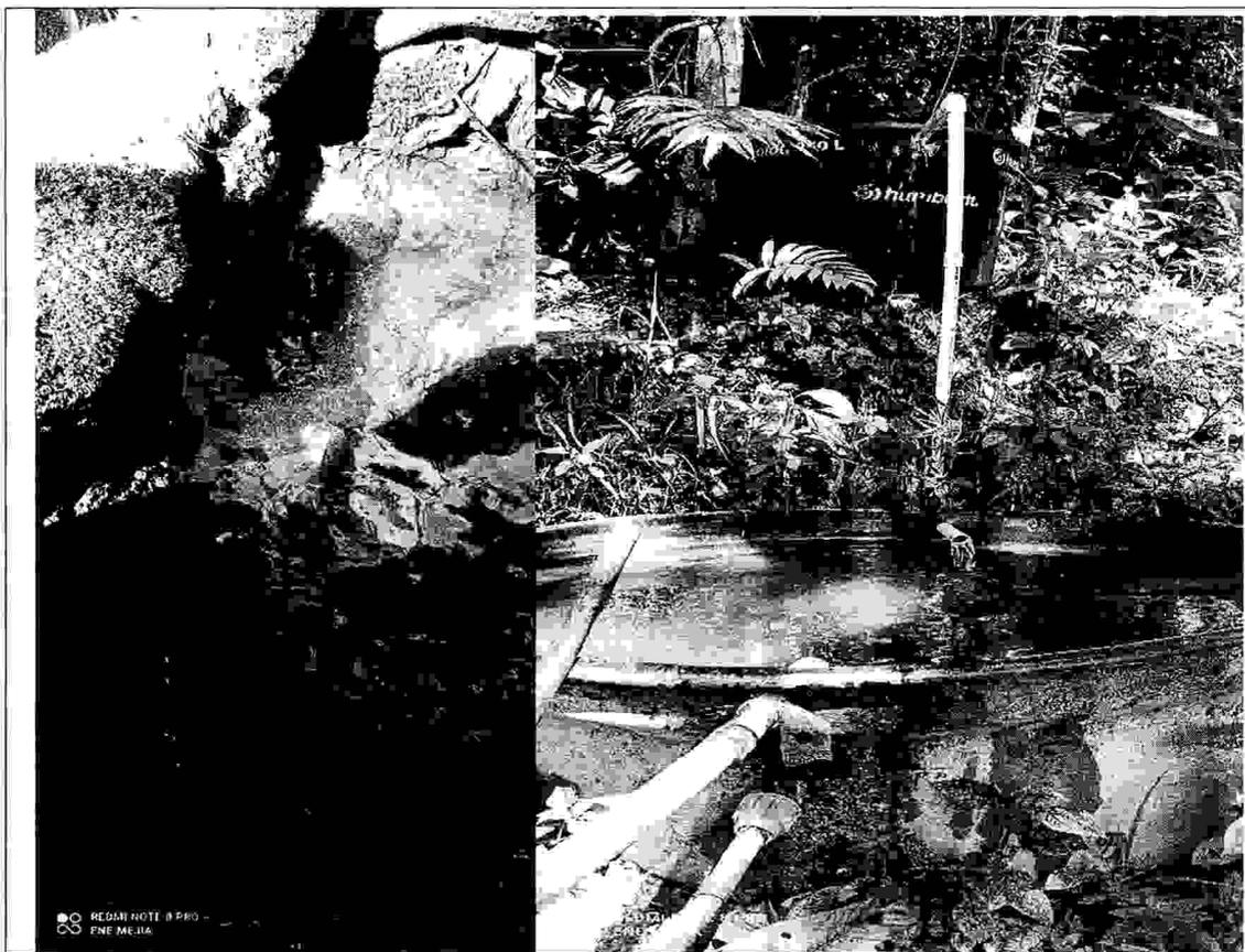
Imagen 6 y 7: Captación, tanque desarenador y de almacenamiento
