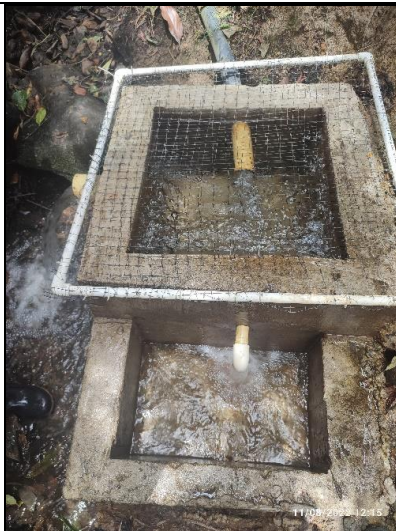
Figura 1. Obra de captación fuente Monte Cristo
