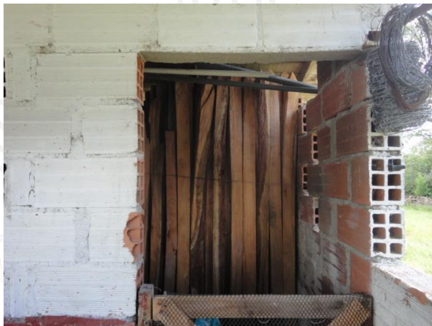
Estacones acopiados en cuarto útil ubicado en el predio.
