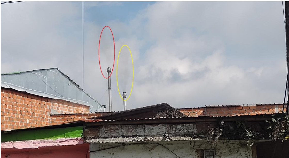
Imagen 1. Vista externa de las chimeneas de la empresa LÁCTEOS RANCHEROS previo a visita de inspección visual.
