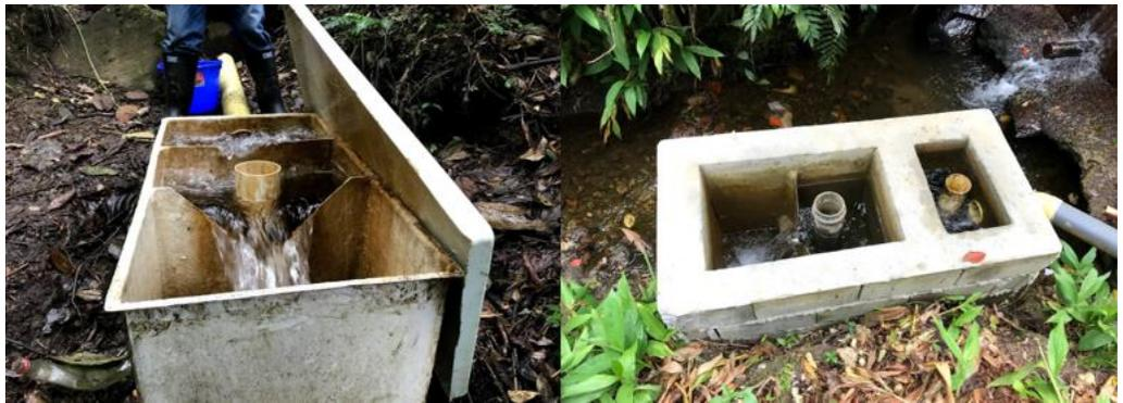
Figura 4: ajas de derivación de caudales.
