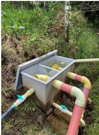
Se realizó aforo volumétrico en la fuente denominada Nacimiento Luna Verde a la entrada de la abertura en la segunda sección de la obra de derivación y control de caudal y arrojó un caudal de **0.70 L/s** caudal similar al otorgado por la Corporación, el cual corresponde a **0.749 L/s** para este usuario.
