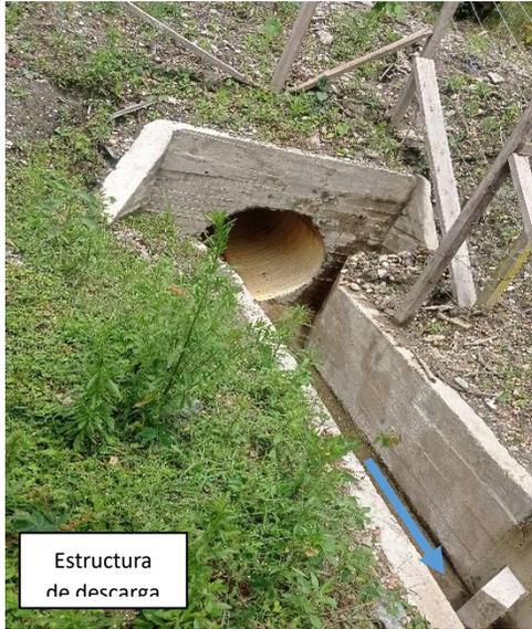
Estructura de descarga
