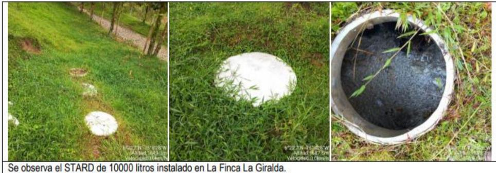
Se observa el STARD de 10000 litros instalado en La Finca La Giralda.
