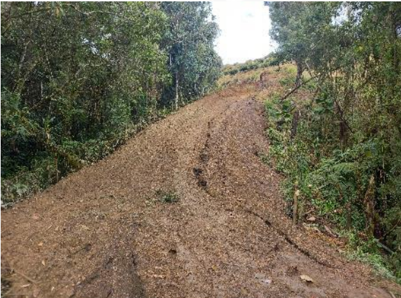
Zona intervenida con el movimiento de tierras
