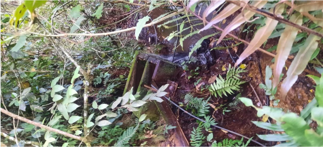
Sitio de captación artesanal con desarenador
