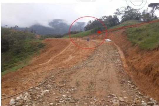
Figura 1: Imagen de la explanación para la construcción de un galpón de cerdos.
