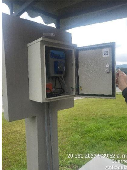
Dispositivo electrónico que hace funcionar el clarificador.
