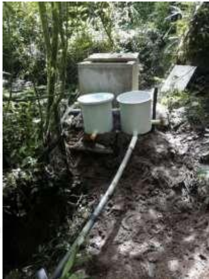
Imagen 1 y 2: Obra de captación y control de caudal fuente La Peñolera.
