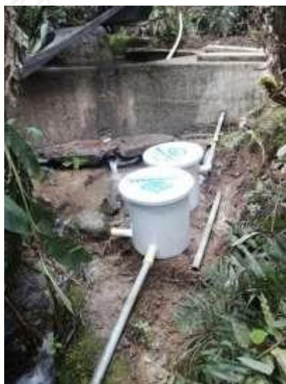
Imagen 4 y 5: Obra de captación y control de caudal fuente Los Alcázares.
