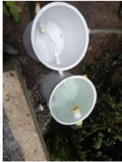
Imagen 1 y 2: Obra de captación y control de caudal fuente La Peñolera.
