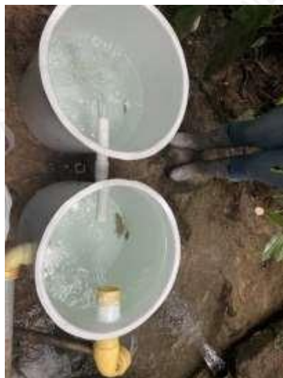
Imagen 4 y 5: Obra de captación y control de caudal fuente Los Alcázares.
