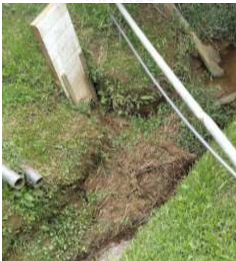
**Foto No 2:** Eliminación de campo de infiltración de Oficinas y descarga a quebrada San Joaquín
