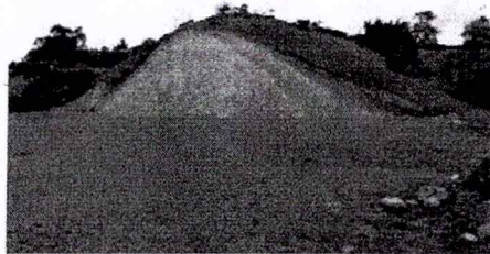
Figura 11. Talud de corte para la adecuación del lleno principal.
