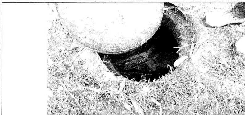
Conexión del proyecto NATIVA Parque Residencial al alcantarillado de la PTAR Cimarronas, Municipio de Rionegro.
