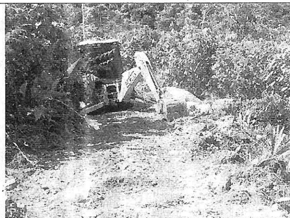
Punto final de la obra
