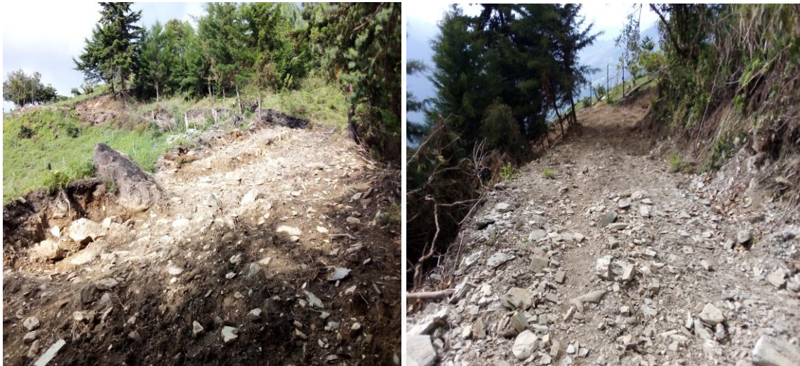
Ensanchamiento de camino.
